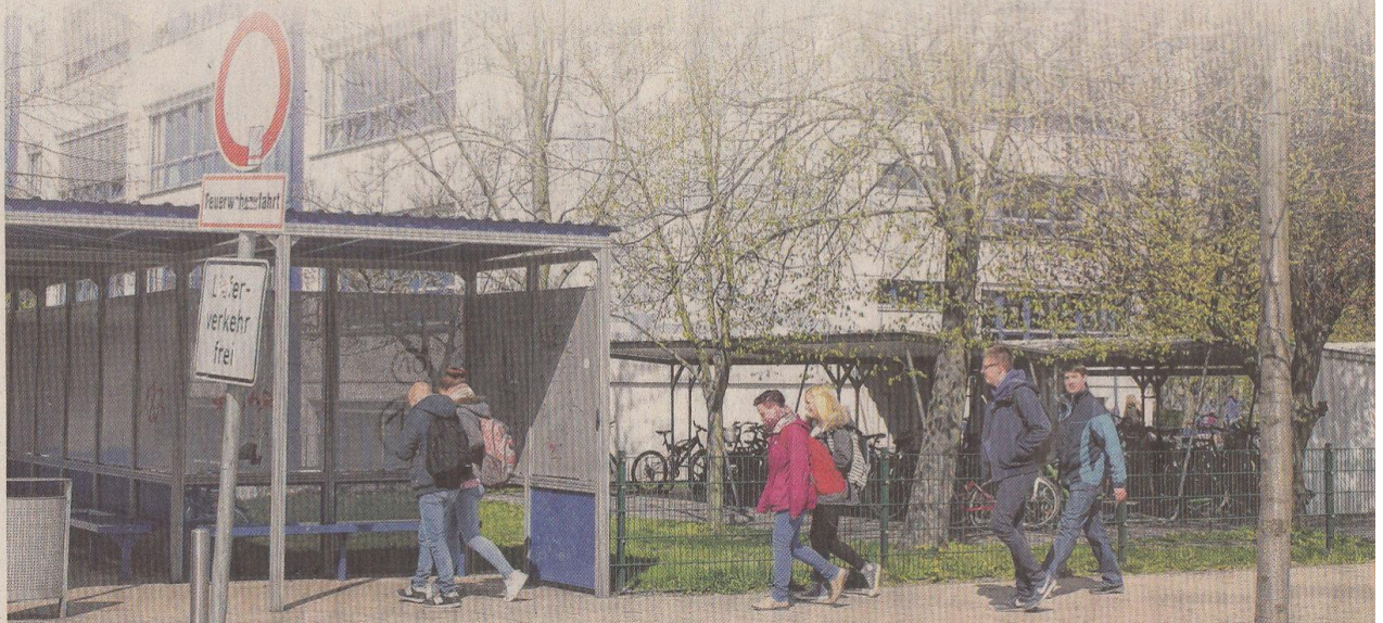
Rund 20 Jahre nach ihrer Einweihung wurde die Schule saniert.
