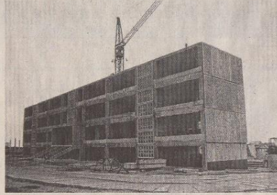
Im Februar 1975 wurde mit der Montage der Schule begonnen.
